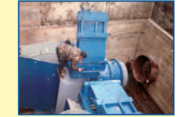
• Transport a montáž turbíny MVE Gudaj - Litva
