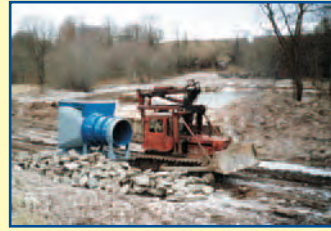
• Transport a montáž turbíny MVE Gudaj - Litva
